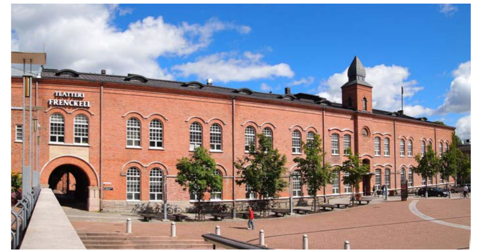
Kuva 18. Frenckellin entisen paperitehtaan pitkä, punatiilinen julkisivu.
